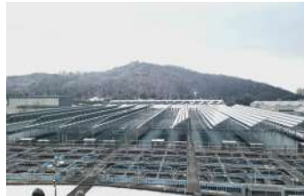
인천시 공촌정수장 고도정수처리시설 건설사업
